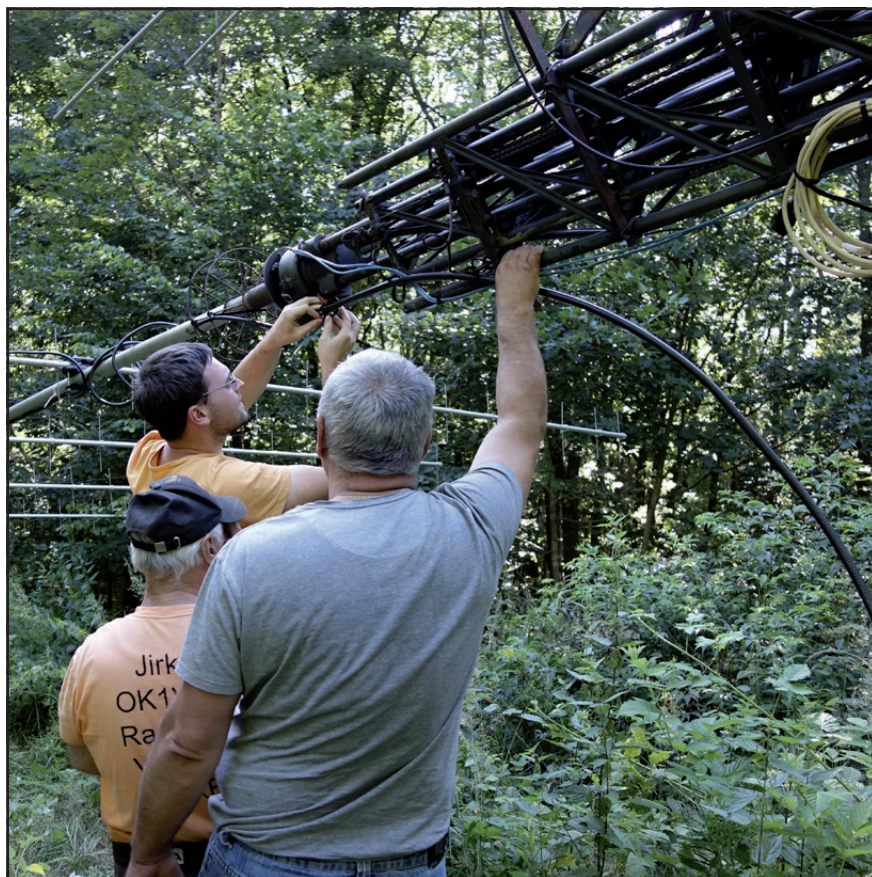
Údržba s menší rekonstrukcí anténní soustavy mobilního vysílače.
